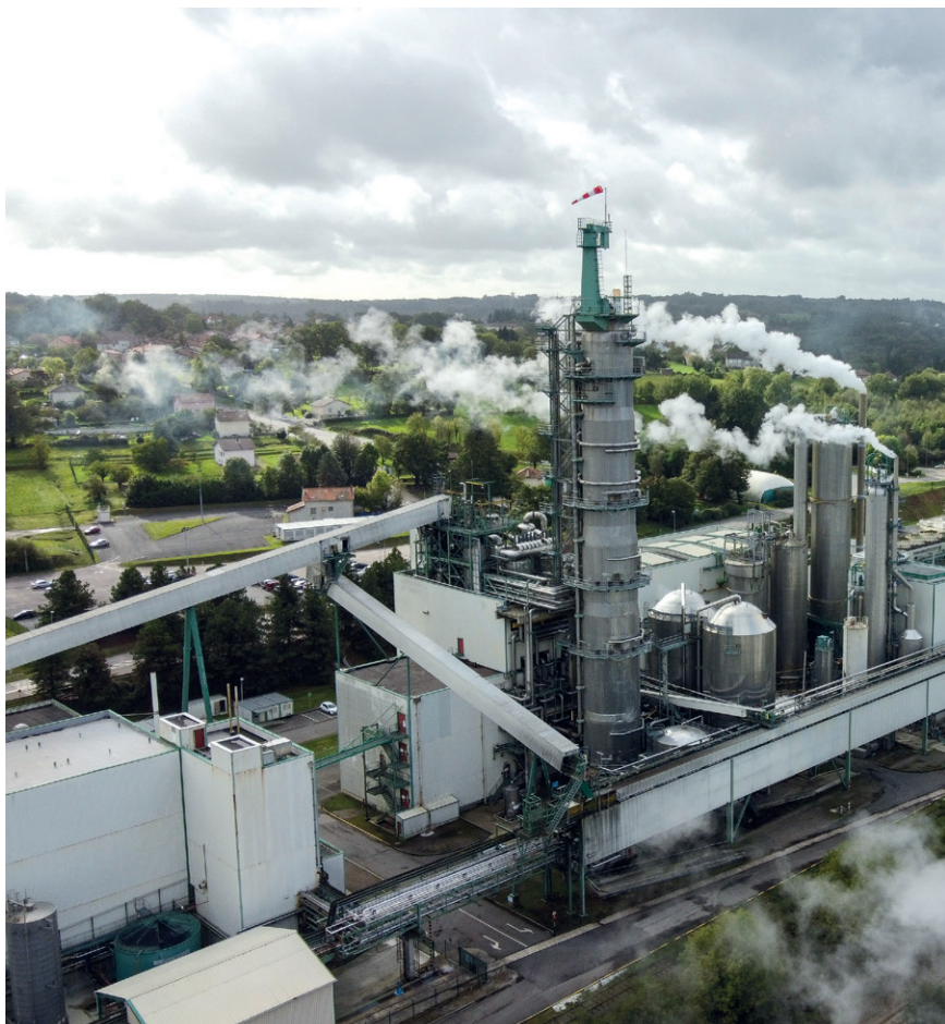
Vue partielle d'une unité de pâte chimique. La valorisation énergétique de la biomasse permet de réduire les émissions de gaz à effet de serre.
